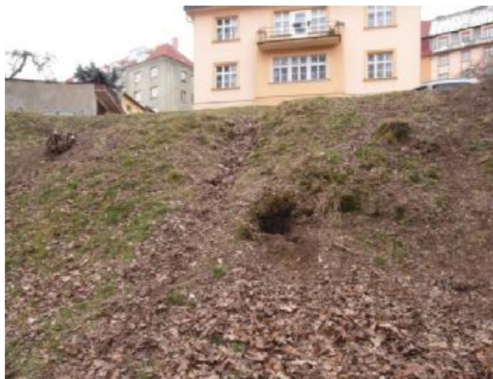
Stávající problematický erodovaný svah bez stabilizačního krytu
